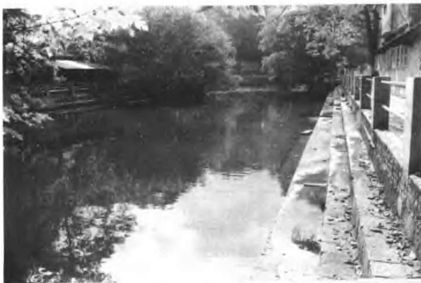
图 7-19 1861 年经重建的柯拜船坞（黄埔船厂李春潮提供）
