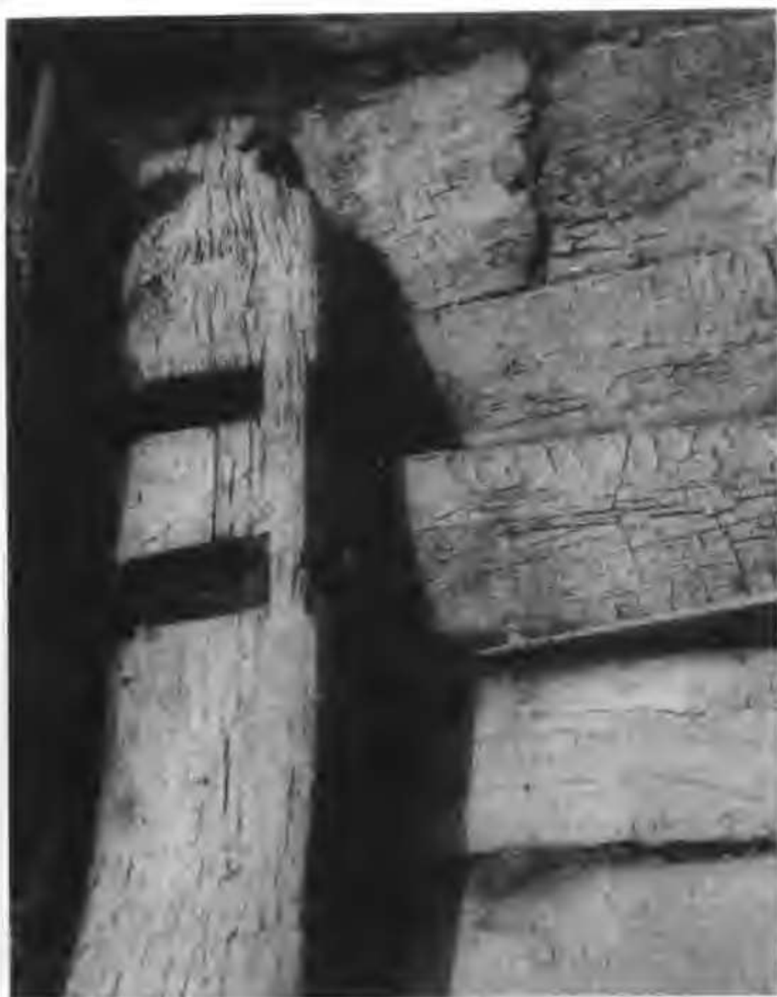
图 5-39 宁波宋船的主桅座（宁波文管会提供）
