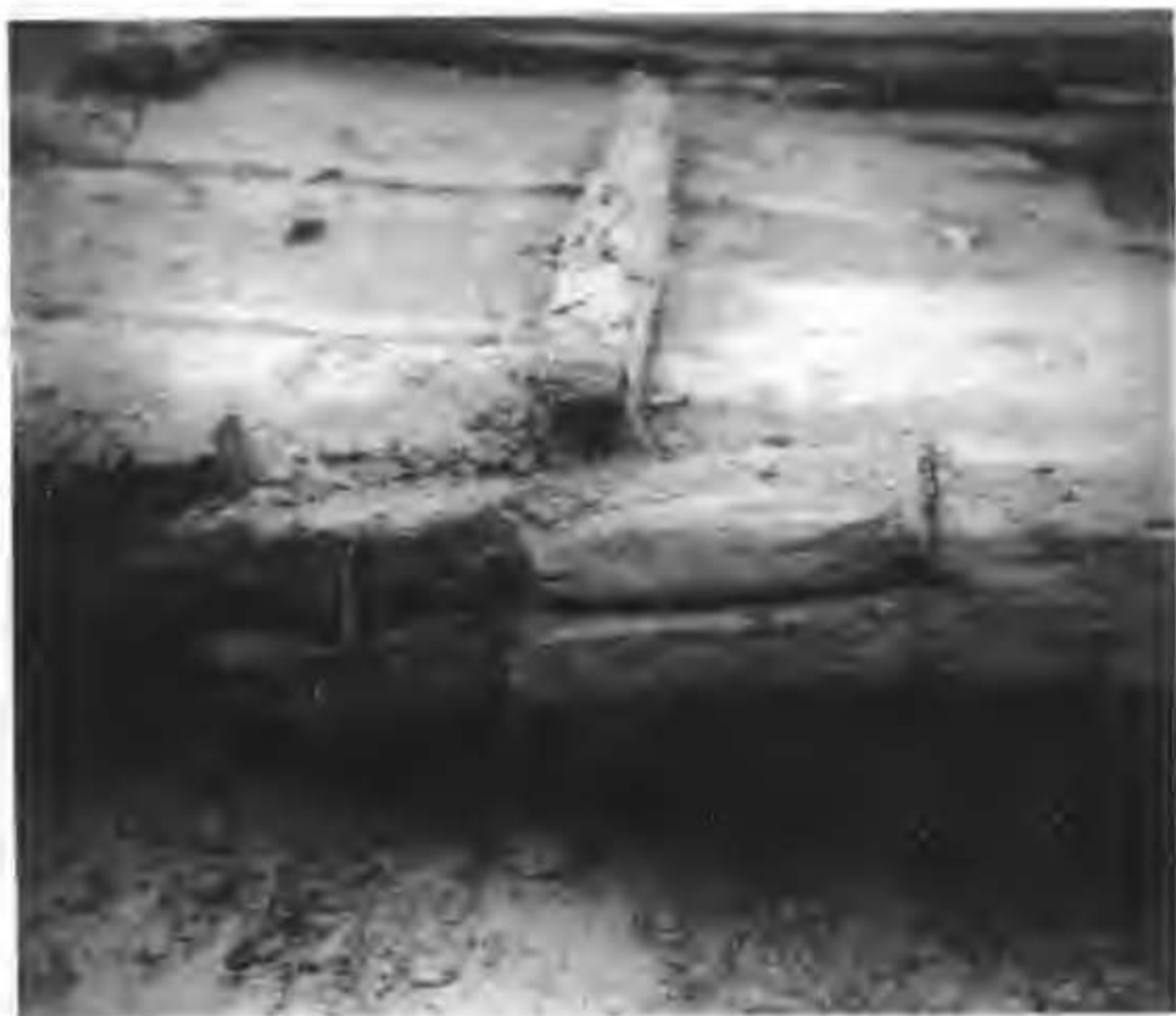
图 5-38 宁波宋船的龙骨采用直角同口连接（宁波文管会提供）
