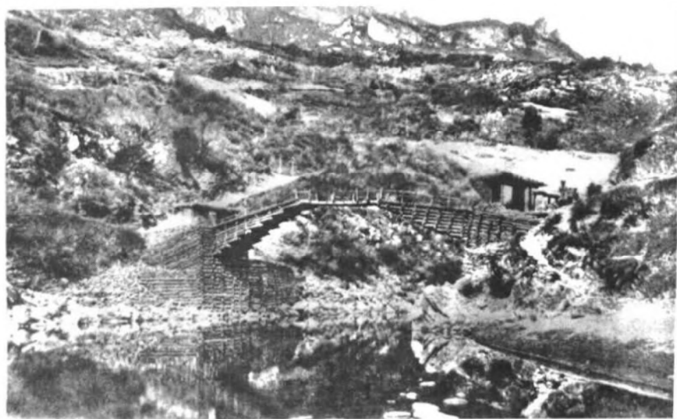
图 2-8-1 四川西部某悬臂桥
