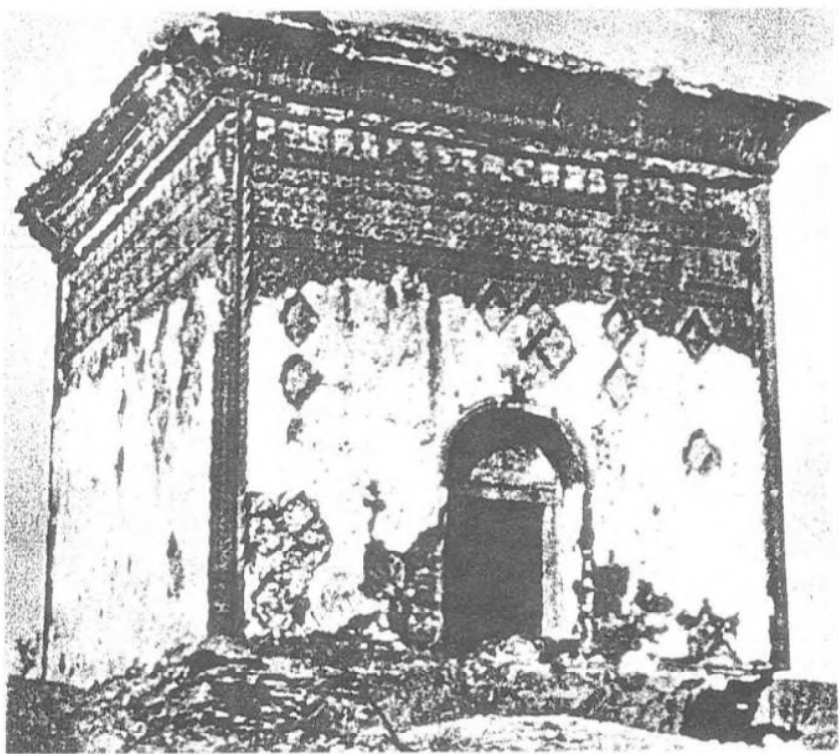
图 3-7-43 河南安阳唐代修定寺塔（1961年状）
