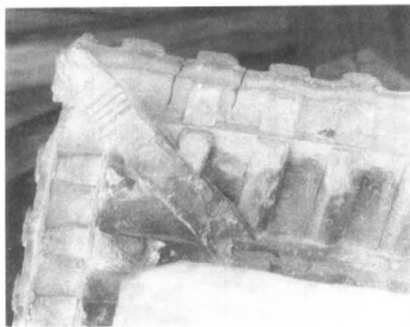
图 2-4-19 河北定兴北齐义慈惠石柱方亭翼角
