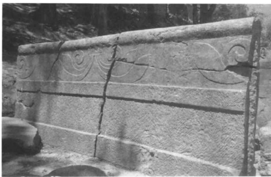
图 3-8-8 河北赵县隋代安济桥上石雕栏板
