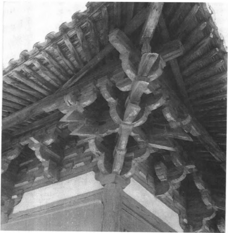
图 2-9-15 山西五台佛光寺大殿翼角
