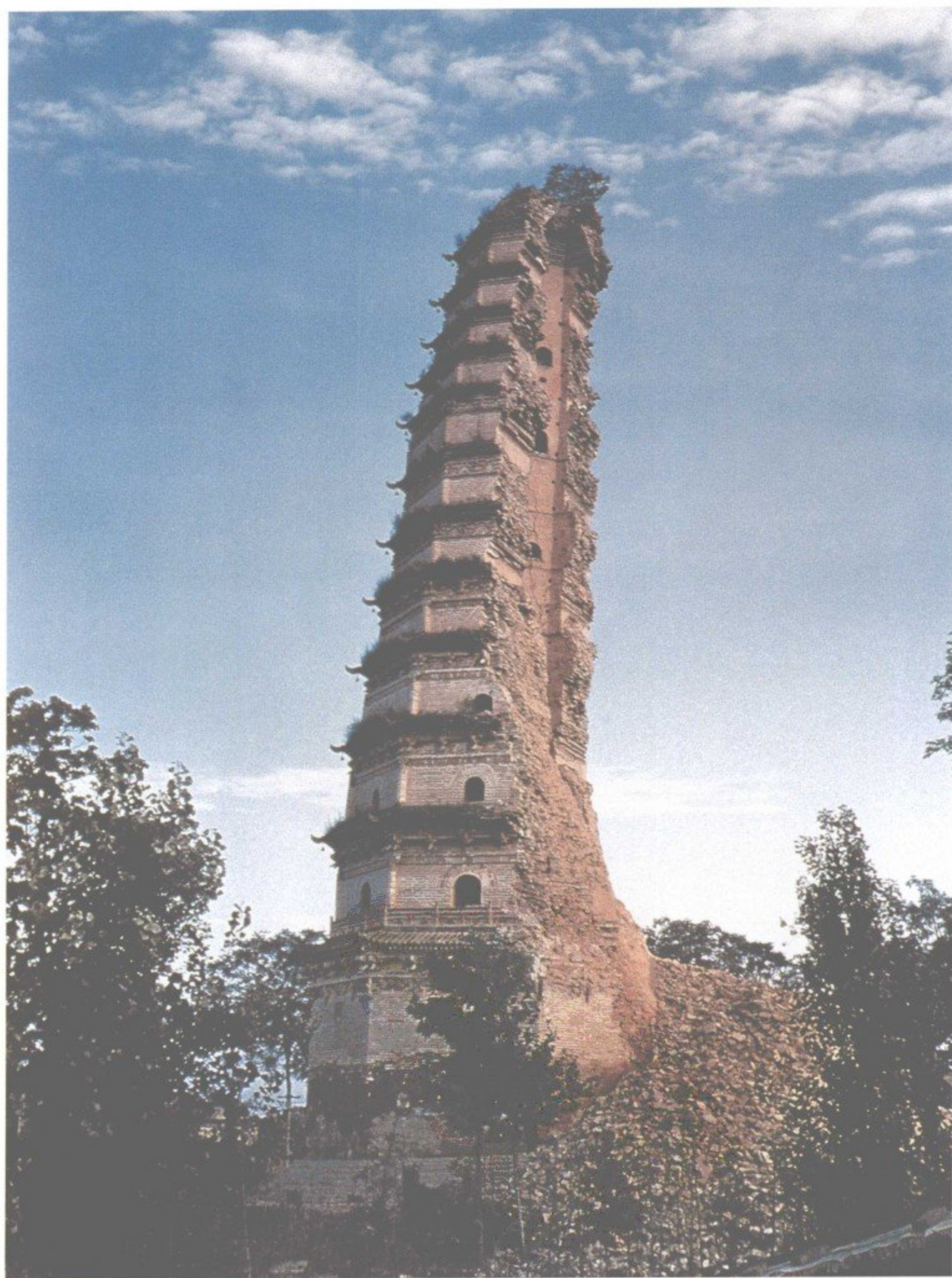
明法门寺真身宝塔崩塌情况（1981年）
